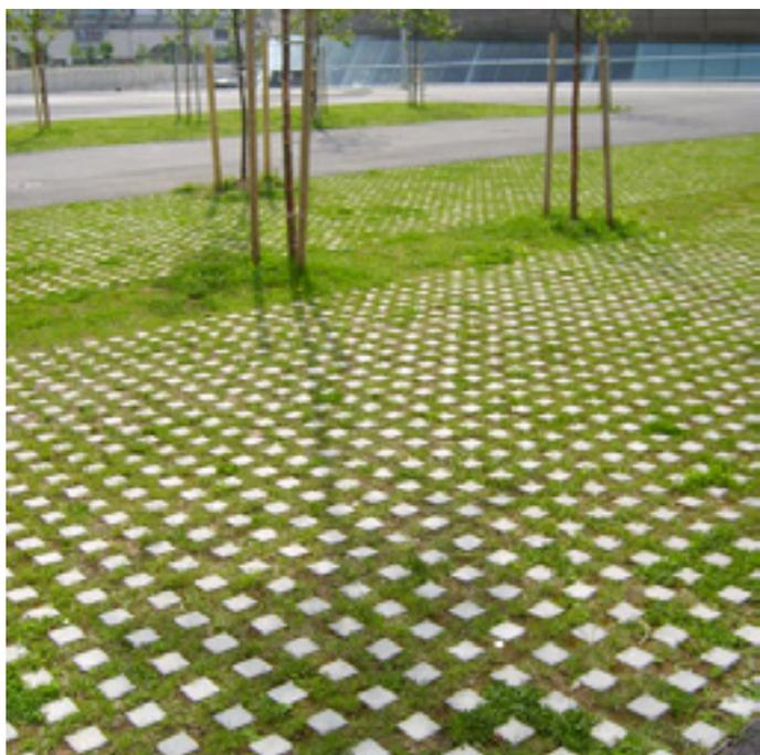
Différents systèmes de plantation de gazon renforcé existent, mis au point et proposés par un certain nombre d'entreprises. Le plus courant est la dalle engazonnée, module en alvéole, posé sur fond de forme compacté et lit de sable, rempli de terre végétale, semé d'un gazon sport. Ce système de végétalisation est destiné aux stationnements à usage modéré ou de voie d'accès pompiers.
