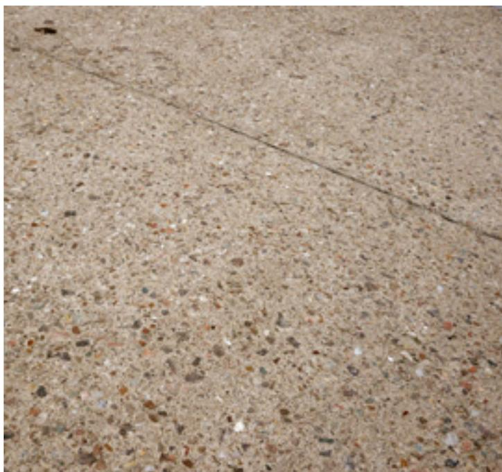
Mélange de granulats (sable et gravillons), d'eau et de ciment, avec éventuellement, selon le rendu voulu, des adjuvants (oxydes métalliques ou pigments de synthèse). Application d'un produit désactivant, ralentissant la cristallisation du ciment en surface, révélant les granulats, avant lavage à haute pression.
